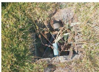
Caixa de passagem elétrica, s/ tampa e fiação exposta
