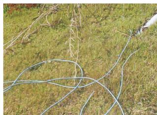
Fiação elétrica exposta, junto ao reservatório de água
